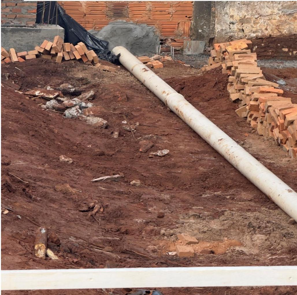
**Tubulação de 6" sendo levada e despejando dentro da tubulação de concreto antiga (tubulação antiga foi vedada para evitar vazamentos e retornos para dentro do terreno da Câmara**
